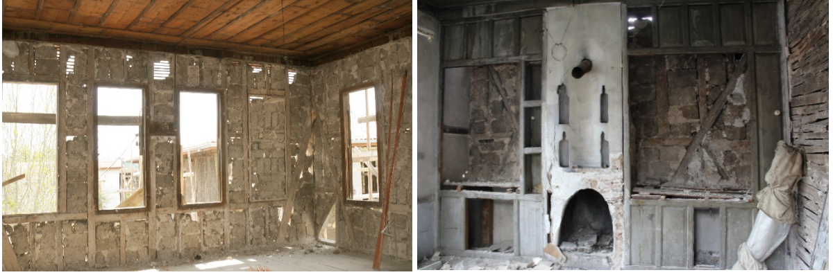
Şekil 7. Ahşap karkas arası kerpiç dolgu (Kaynak: Yazara ait fotoğraf arşivi)
