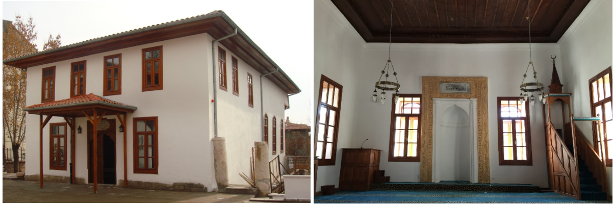
Şekil 1. İmaret Camii 2014-2016 restorasyonu sonrası dış cephe ve harim (Kaynak: Yazara ait fotoğraf arşivi)
