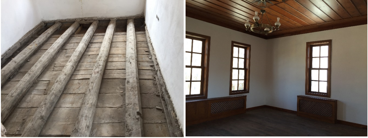
Şekil 8. Ahşap döşeme kirişleri ve ahşap döşeme kaplaması (Kaynak: Yazara ait fotoğraf arşivi)
